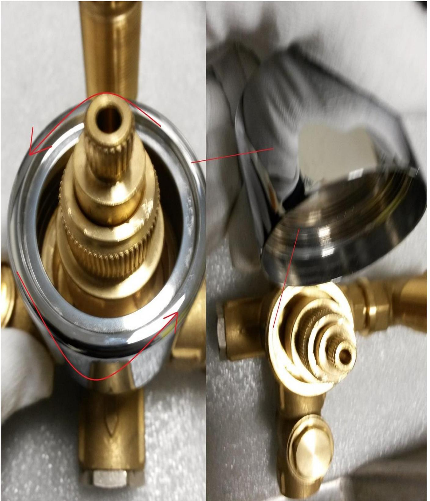
**7-Dévissez la bague chromé dans le sens inverse des aiguille d'une montre.**
